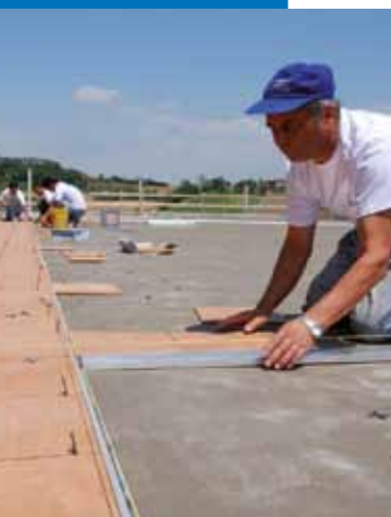
Pose de carrelage avec Kerabond T + Isolastic
