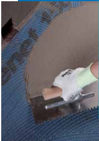
Application d'une couche de Mapelastic sur Mapenet 150
