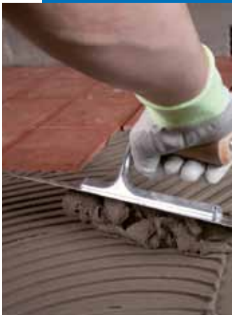
Mise en œuvre de Granirapid sur Mapelastic
