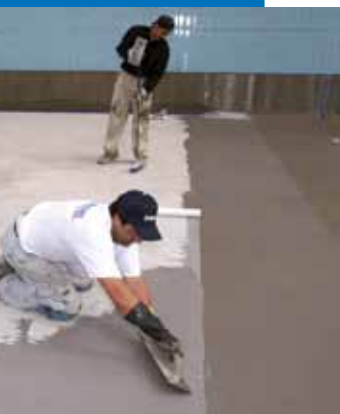
Imperméabilisation d'une piscine avec Mapelastic
