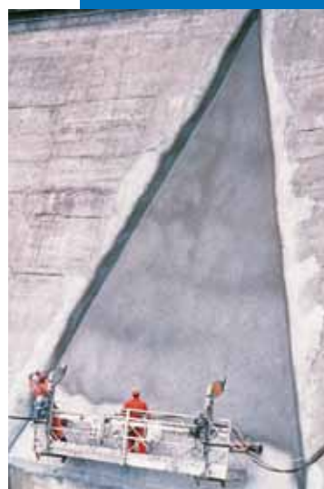
Exemple d'application à la pompe à mortier de Mapelastick sur un barrage
