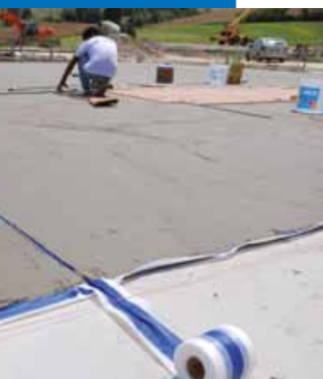
Imperméabilisation des supports avec Mapelastic et Mapeband
