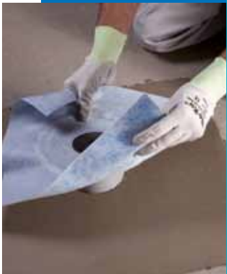
Pose d'un siphon de sol sur Mapelastic
