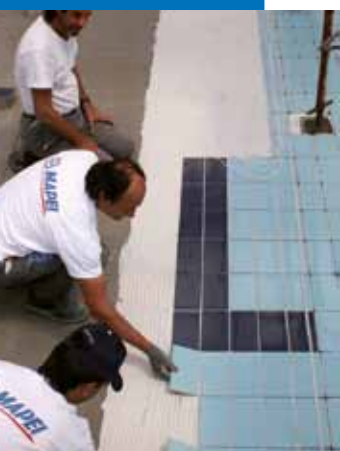
Pose d'un revêtement céramique sur Mapelastic
